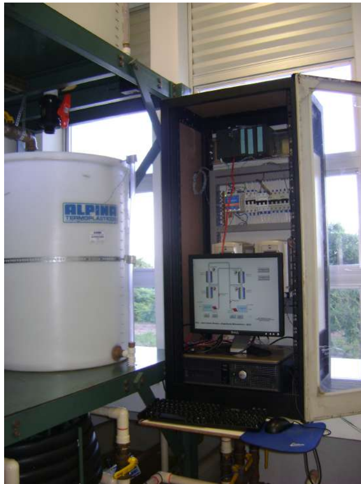
Figura 2.13: Painel elétrico construído
