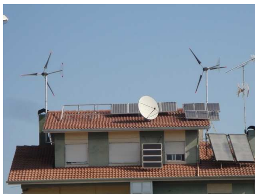
Figura 8.1: Turbina eólica de eixo horizontal de três pás Fonte:( http://www.assimsefaz.com.br )
