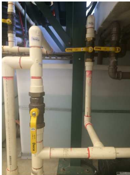
Figura 3.2: Conjunto de válvulas responsáveis pelo recirculamento da água nos tanques
