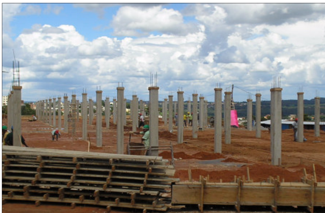
CAMPUS RETOMADAS NO FINAL DO ANO PASSADO, AS OBRAS DA SEDE DO CEFET-MG DE DIVINÓPOLIS FICAM PRONTAS NESTE ANO
